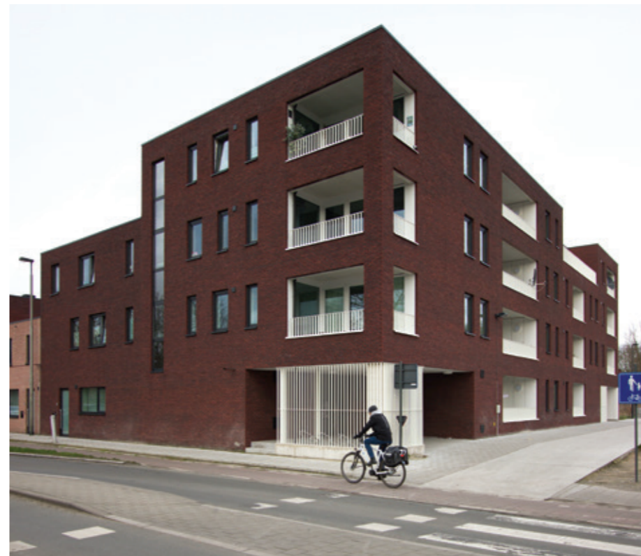
Nieuwbouw Bernmaaiweg, site Zeemanstuin in Gent.
